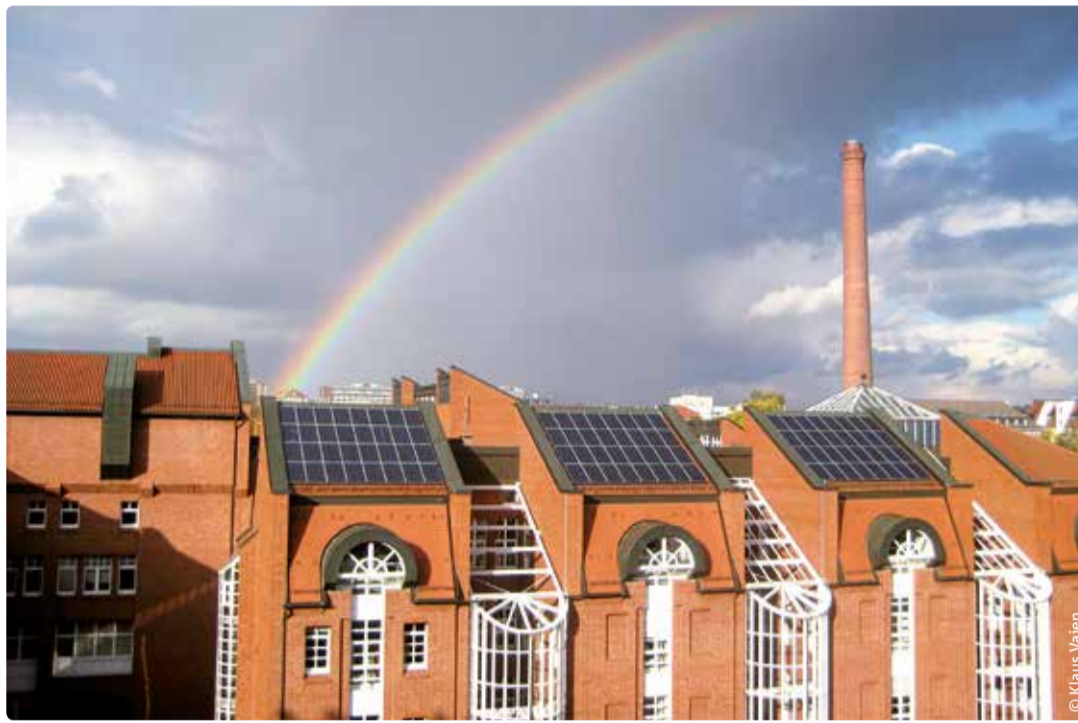
Die Photovoltaik-Anlage auf dem Dach der Uni-Bibliothek ist das Aushängeschild des Projekts solarcampus.
