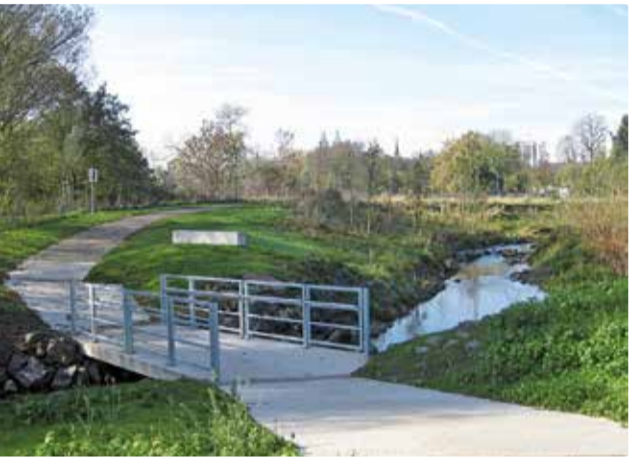
Die Freifläche am Fuldaufer war das größte Projekt im Rahmen des Förderprogramms „Soziale Stadt“
